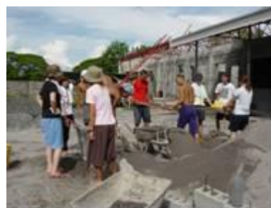
施設の建設作業
