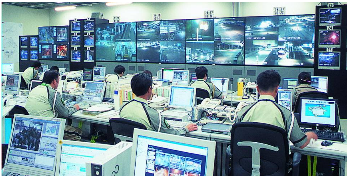
ITS (Intelligent Transport System) センター
