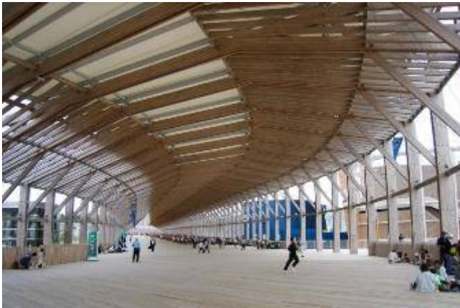
北エントランスの木造トラス構造
